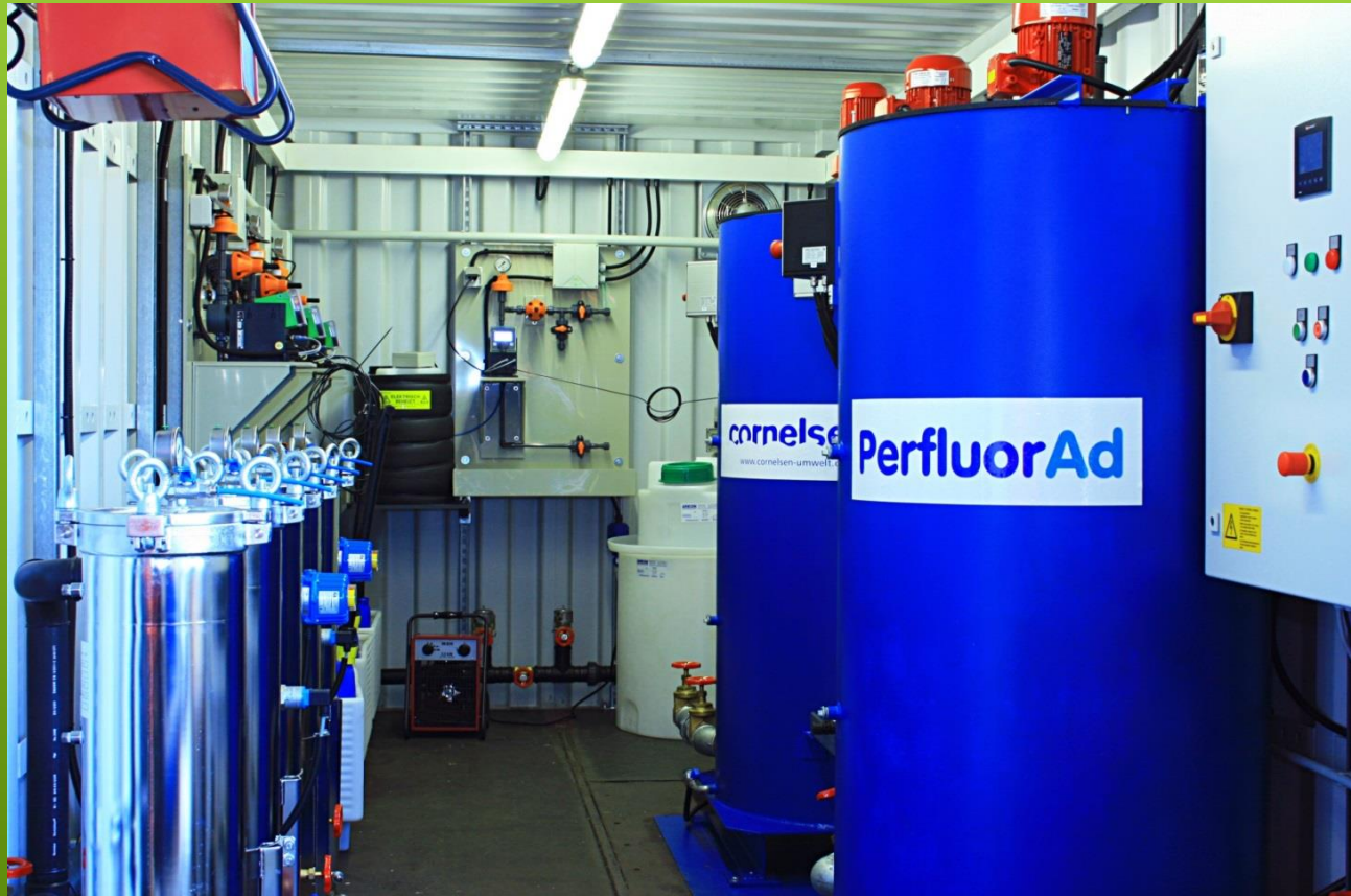
Mobile PerfluorAd-Löschwasserreinigungsanlage (MLB) (eingebaut in 20'-Container)
